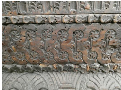
Presenza di fori di sfarfallamento
